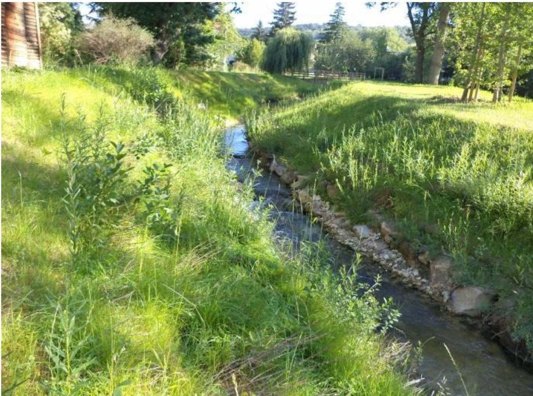
Exemple de travaux de mise en œuvre de pied en enrochement surmonté de lits de plants et plançons
