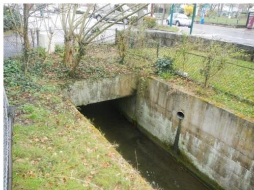
Les berges sont matérialisées par des murs en béton verticaux recouverts de lierre. Le cheminement est rectiligne et uniforme et on remarque une absence totale de substrat au sein du lit. Des canalisations d'eaux pluviales se raccordent à plusieurs endroits du canal.
